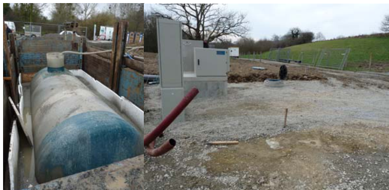
Figure 104 : Travaux de construction d'un nouveau poste de refoulement et d'une bache de sécurisation sur la commune de St-Planchers
